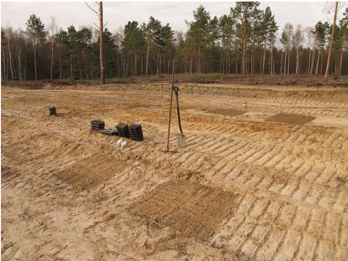
Flächenvorbereitung zur Ansaat und Auspflanzung von Sandtrockenrasenarten nach Rodung und Oberbodenabtrag auf einer Binnendüne im Dahme–Heideseengebiet in Brandenburg.
