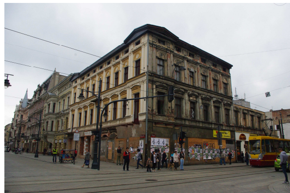
Halb renoviertes Gebäude in der Ulica Piotrowska
