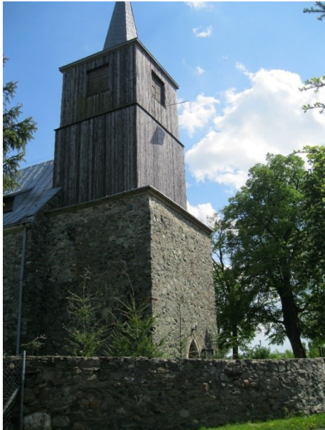
Die Kirche in Wilczkowice. Eigenes Bild.
